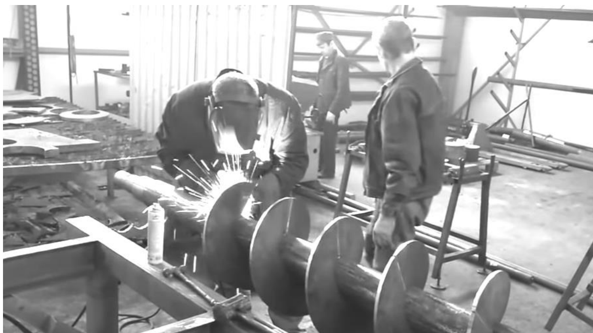
Рисунок 6.1 – Сварочный стол для выполнения восстановительных работ шнеков и барабанов фрез кормораздатчиков в ОАО «Столбцовское ПМК»
