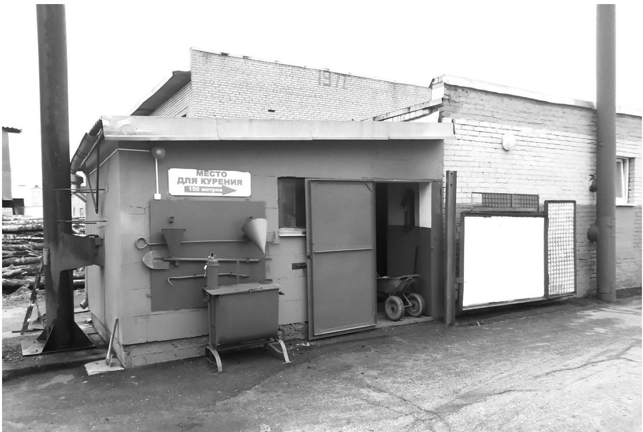
Рисунок 7.1 – Пожарный щит с первичными средствами пожаротушения
